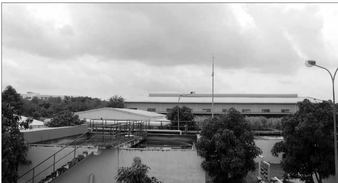
▲ KCN Long Hậu, tỉnh Long An đầu tư hệ thống xử lý nước thải với công suất 4.500 m 3 /ngày, đêm
