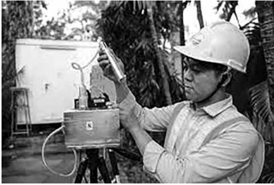
▲ Lắp đặt thiết bị đo quan trắc CLKK tự động ở khu đô thị
