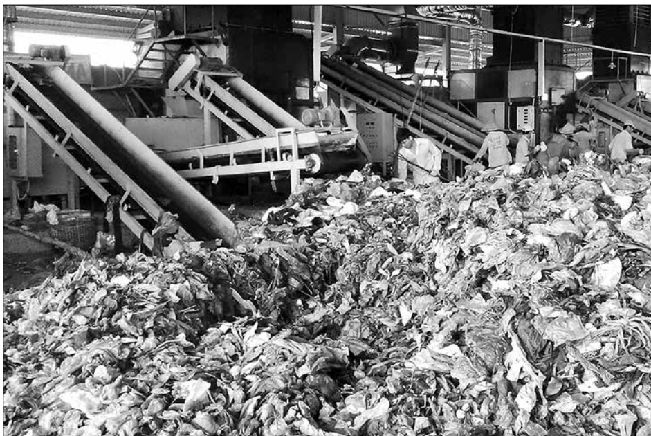
▲ Hệ thống xử lý rác thải sinh hoạt tại Nhà máy xử lý CTR Ô Môn, Cần Thơ
